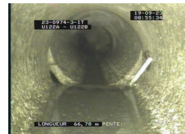
Déplacement d'assemblage avec exfiltration
