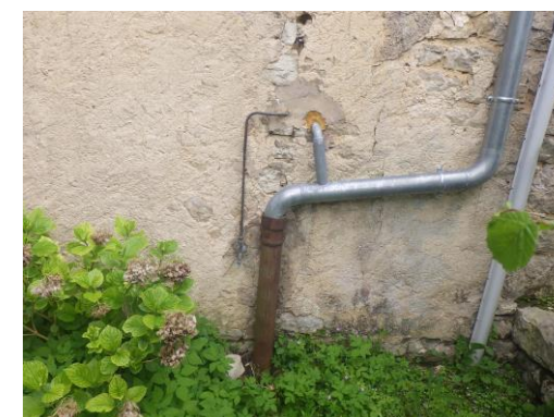
Rejet d'eaux usées s'infiltrant dans le sol – 14, rue du Marquis
