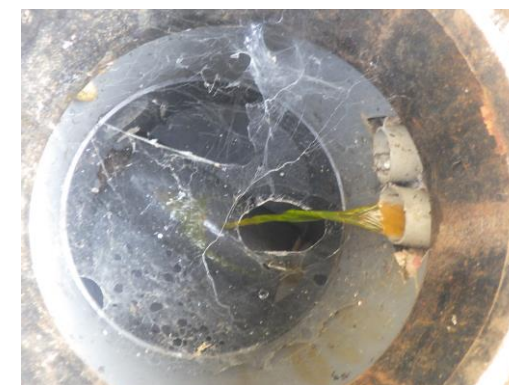
Rejet d'eaux usées dans les réseaux d'eaux pluviales – 2, rue du Revermont
