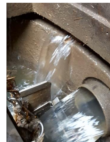
PR des Orchidées – Deux intrusions d'eaux claires au droit de la réhausse – débit estimé à 3-4 m 3 /h
