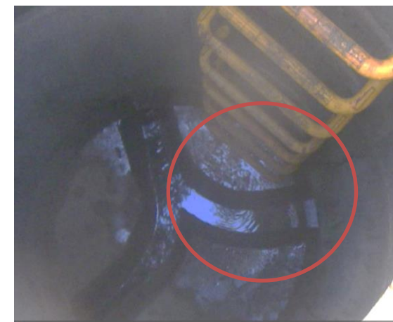
Regard n° 236 – Intrusion d'eaux claires au droit du radier - débit estimé à 0,3 m 3 /h
