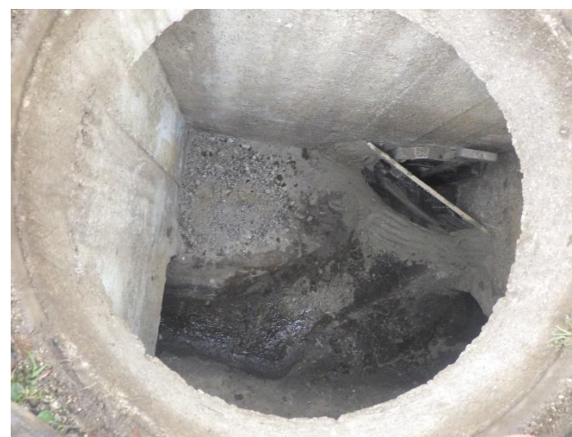
Vue de l'ancien déversoir d'orage avec condamnation partielle de la canalisation vers le PR lors de la campagne
