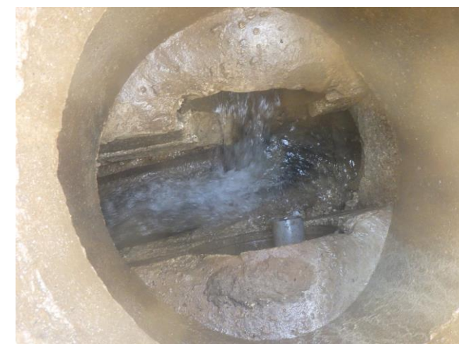
Regard n° 240 – Intrusion d'eaux claires en provenance de la parcelle AD 0301 lorsque les sols sont saturés
